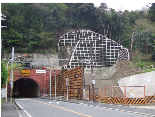
新設トンネルの上部を保護するための準備工事(逗子側)
