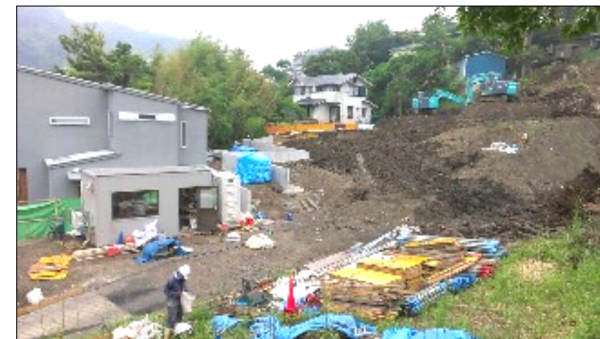
工事中的一色宅地開発
